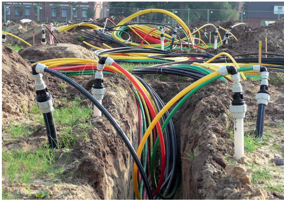
Sogenannte In-Situ-Sanierung: Das Grundwasser des kontaminierten Bodens wird abgepumpt und gezielt mit speziellen Stoffen angereichert und zurückgepumpt. Die verschiedenfarbigen Schläuche deuten auf die unterschiedlichen Tiefenschichten des Spülkreislaufes hin. Giftige Stoffe sollen sich langfristig zu ungefährlichen Substanzen zersetzen.
